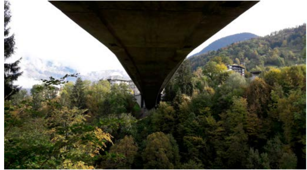
Vue du dessous du Pont - Saint Gervais
